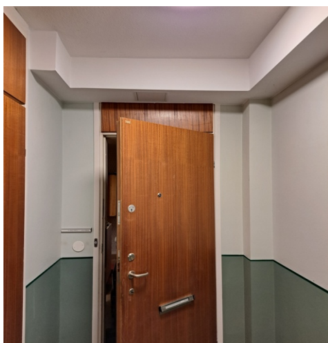
Bild 1. Färdigt utseende i trapphus. Ledningarna ligger bakom den gipsade lådan i taket.
