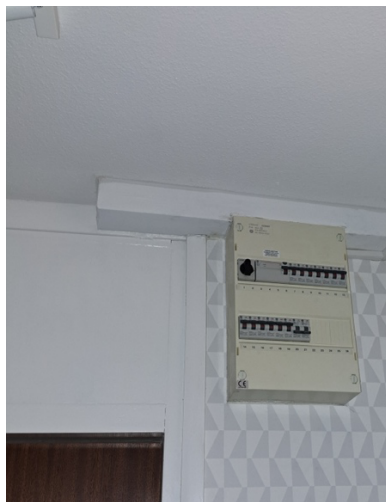
Bild 3. VVC-ledning inbyggd i hall i bostad.
